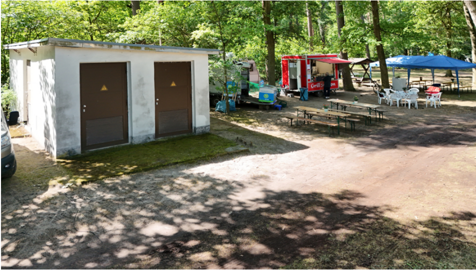
Trafostation und Imbiss mit Außengastronomie
